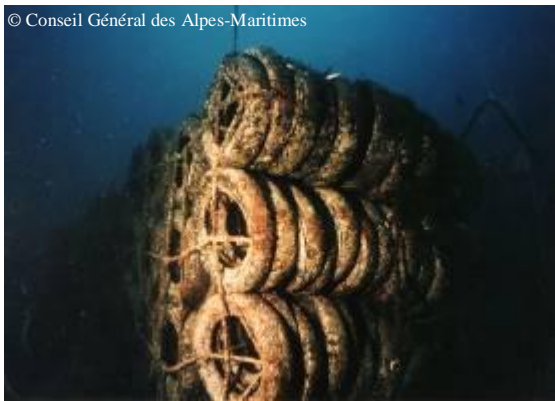
Illustration 85 : Pneumatiques de la Zone Marine Protégée de Golfe Juan agencés en barrière : avec le temps et le mouillage illégal de grosses unités dans cette zone, la structure s'est démantelée, les pneumatiques sont maintenant en tas chaotique, plus ou moins dispersés par les courants.
